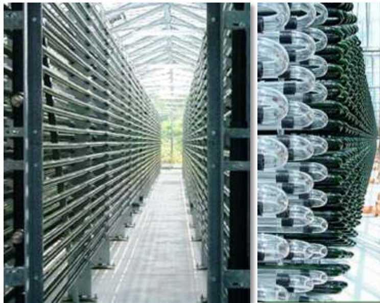
Figure 12 : Photobioréacteur de l'usine Allemande de Klötze. (Source : Roquette)
